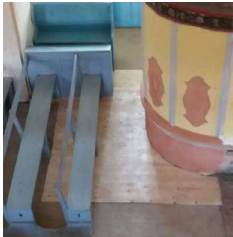
Fußboden vor der Kanzel neu verlegt
