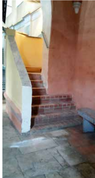
Neu geflieste Treppe an der Kanzel - August 2016
