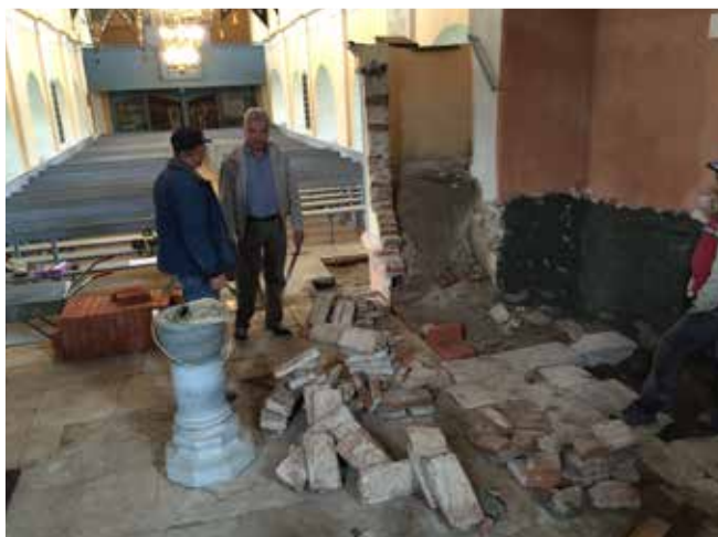
Sanierung der Kanzel - Juni 2016
