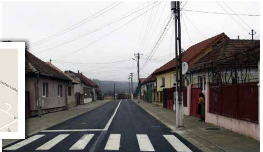
Modernisierte Ion-Creangă-Straße in Talmesch
