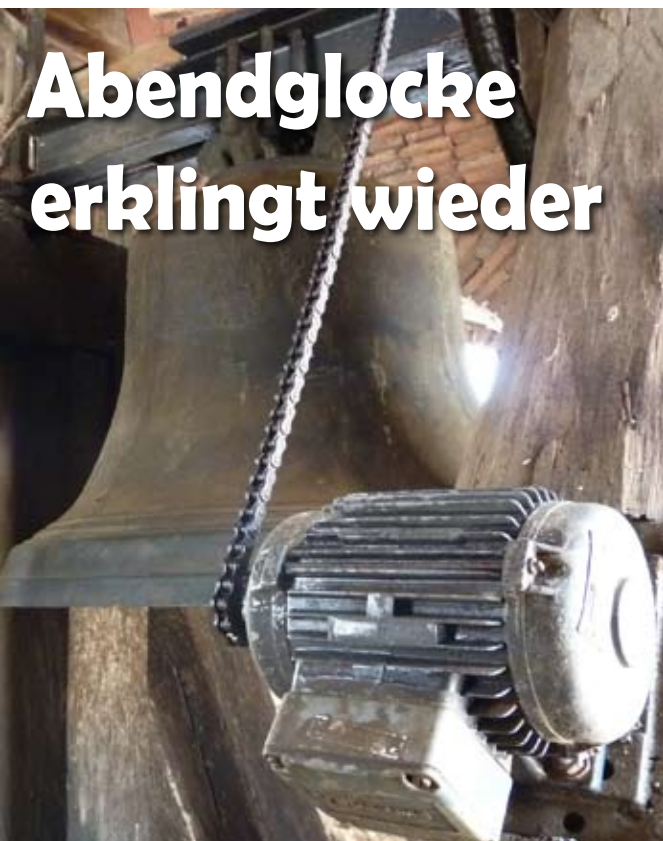
Motorantrieb der kleinen Glocke
