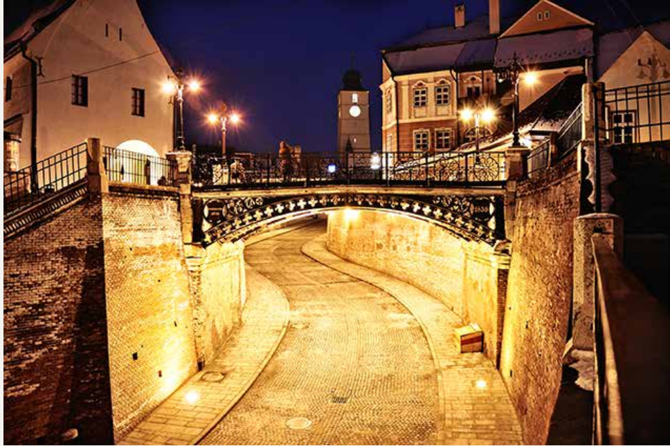
Die „Lügenbrücke“ überspannt die Unterführung in die Unterstadt
