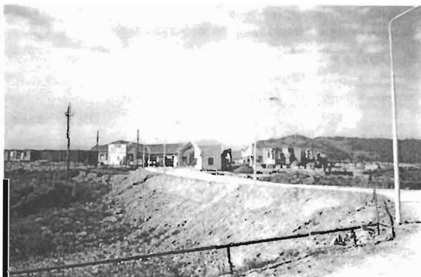
Neues Industriegebiet Einfahrt Talmesch ( von Hermannstadt kommend)
