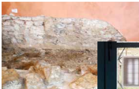
Mörtel und Steine wurden zur Beseitigung des Hausschwammes entfernt
