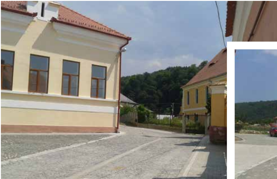
Neu gepflasterte Straße zur Kirche
