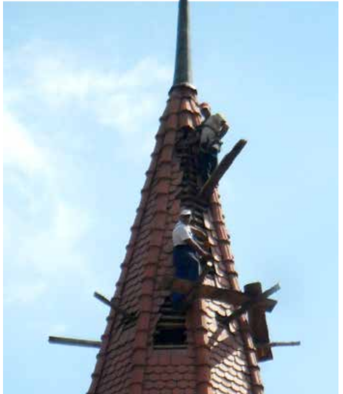
Dachdecker bei der Umsetzung der Vorsorgemaßnahmen
