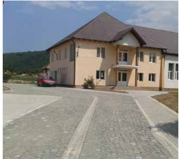
Die neu gepflasterte Straße führt zum Gemeindesaal und zur Kirche
