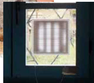
Lüftungsgitter am Fenster
