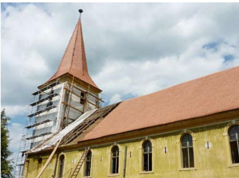
27. Juli 2009 – das Baugerüst umschließt den Kirchturm und das Kirchendach wird mit neuen Dachlatten und Dachziegeln gedeckt.
