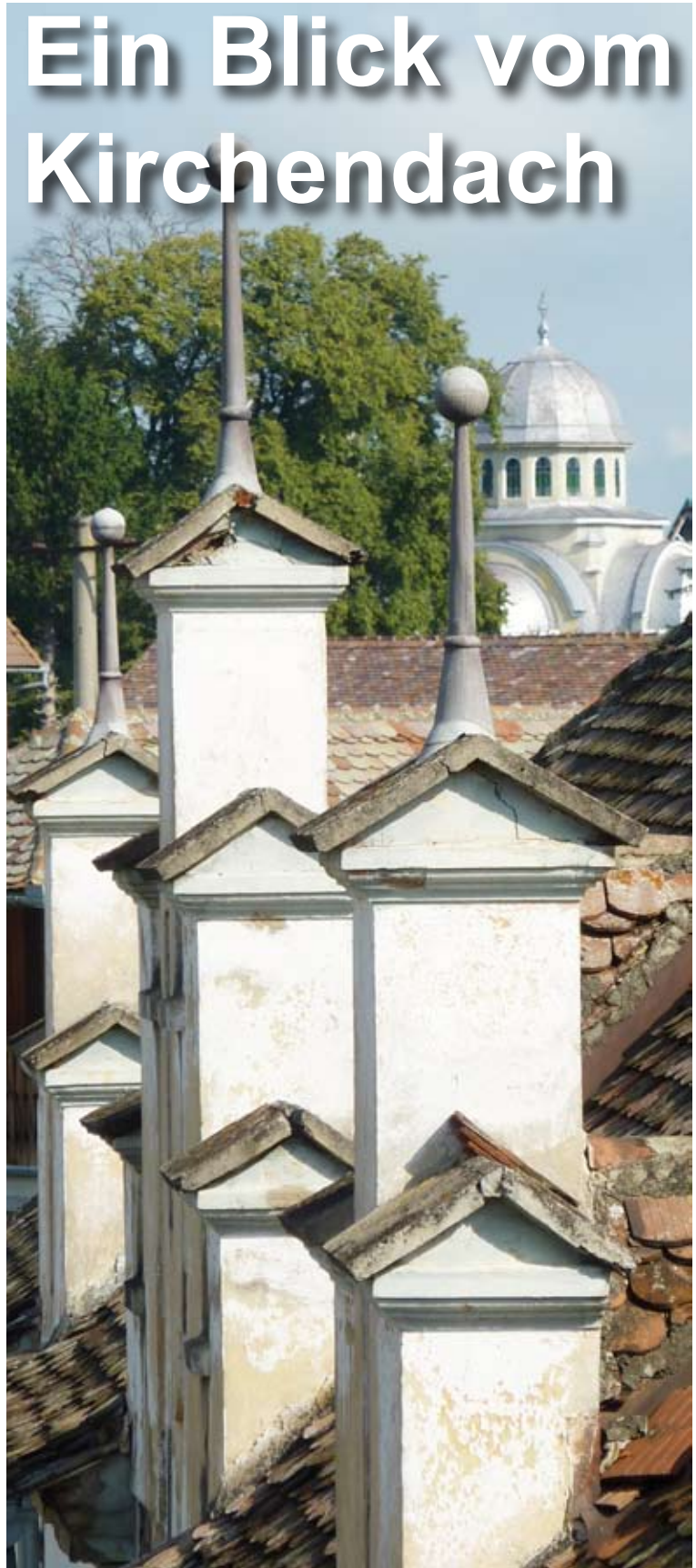
Einmaliger Blickfang während der Restaurierung unseres abgedeckten Kirchendaches 2009 Zu sehen sind die drei Schultürmchen im Vordergrund und das Dach der orthodoxen Kirche im Hintergrund.
