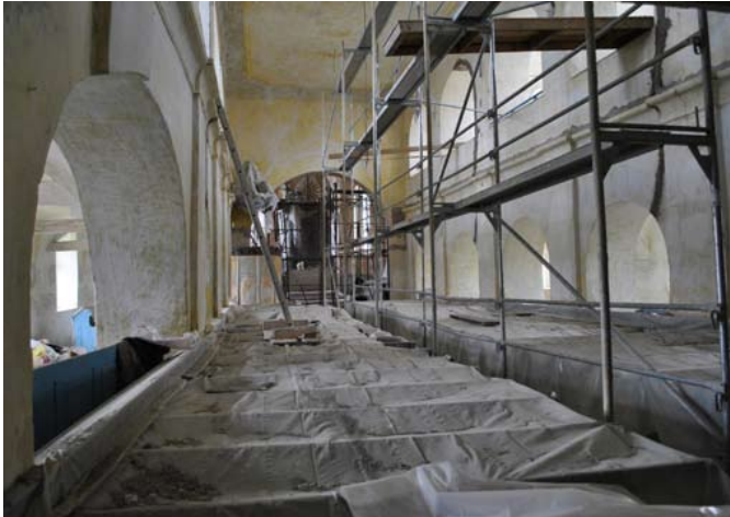
Mai 2010: Die Innenrenovierung hat begonnen.
