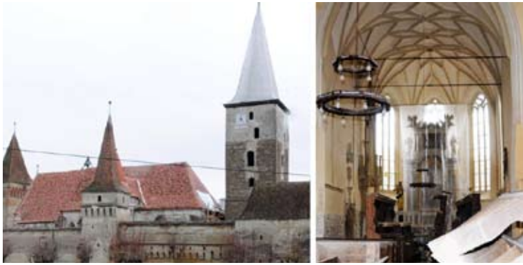
Kirchenburg in Meschen - Innenrenovierung
